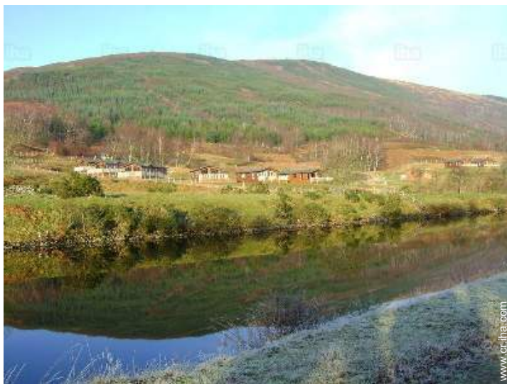
vista de conjunto
