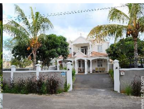
vista sobre la calle/la avenida
